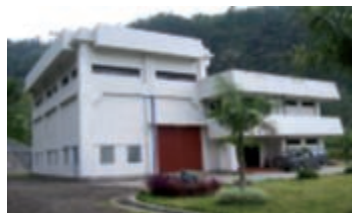
MINI-CENTRALE HYDRAULIQUE DE MALANG POUR PNL
